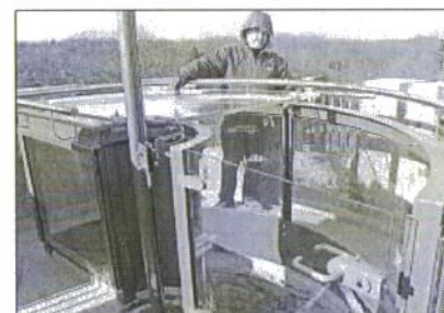
So sieht er aus: der neue Glausausstieg auf dem Forstturm, den Ivan Gentschev von Firma Metallbau am gestrigen Freitag installiert hat. Foto: tlz/Michael Groß
